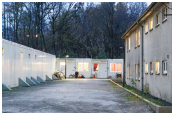
Energetische Ertüchtigung von Flüchtlingsunterkünften
