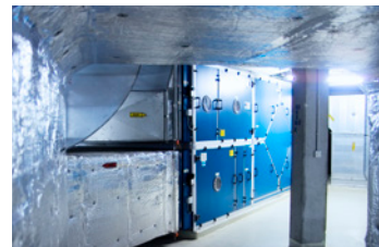
Sanierung von Lüftungsanlagen in Hallenbädern
