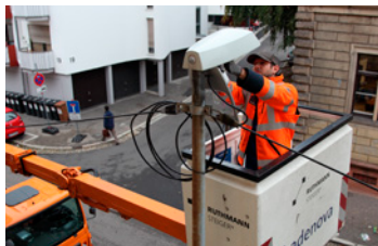
Erneuerung der Straßenbeleuchtung
