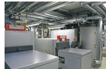
Heizungserneuerung in Schulen
